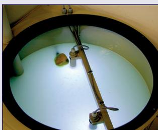
UVSpear eingebaut in einem Arbeitsbehälter einer Prozesswasseraufbereitungs-Anlage.
